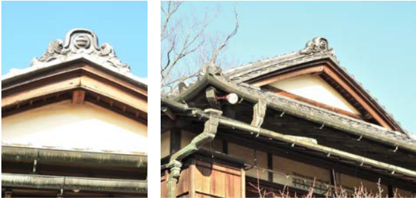
図15 中棟2階西側屋根の切妻上の鬼瓦
