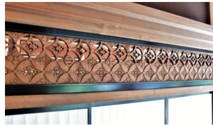
図8 中棟大広間付け書院の欄間
