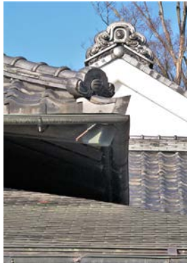
図16 手前西棟屋根と奥が土蔵 屋根妻側
